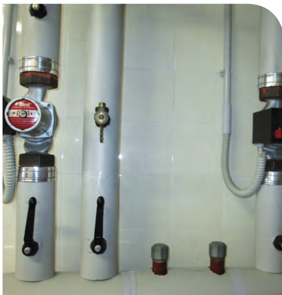
Links oben: Rohre teils ohne Dämmung im Bereich der Pumpen
